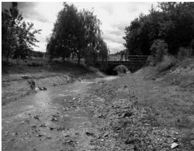
Bild 7: Renaturierungsabschnitt Mannichswalder Sprotte nach erstem Hochwasser gegen Ende der Bauphase
