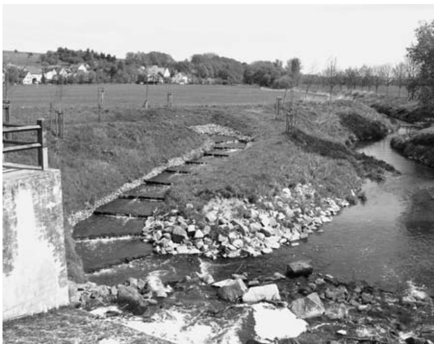
Bild 5: Umgehungsgerinne am Papiermühlenwehr Großstöbnitz mit pendelnder Strömung im Gerinne und sichtbarer Lockströmung in die Sprotte
